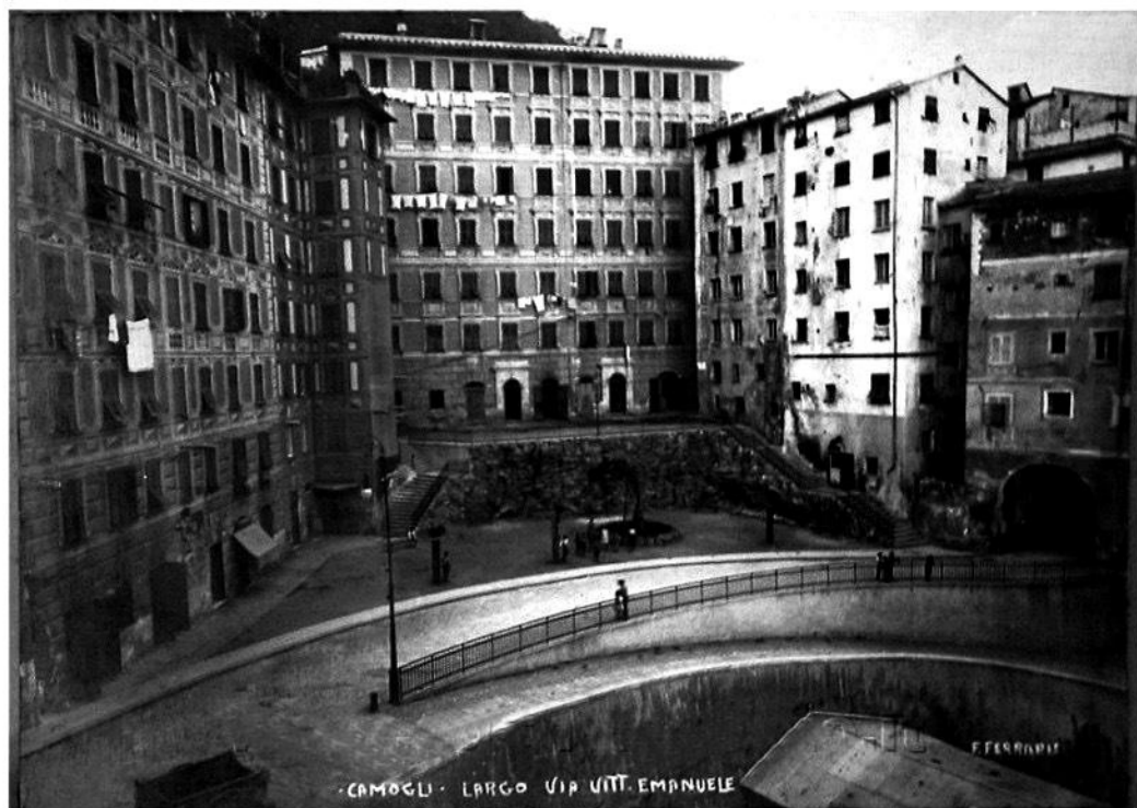
Dopo i lavori dello scalo di costruzione
