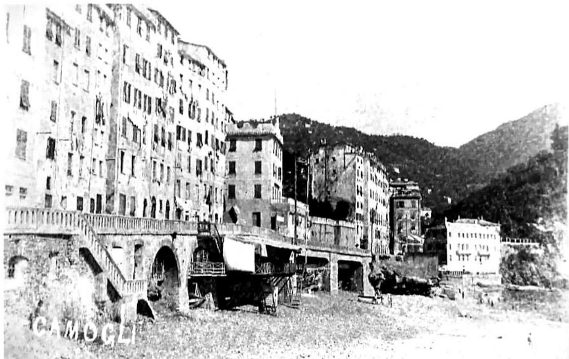
Dopo i lavori di Via Garibaldi
