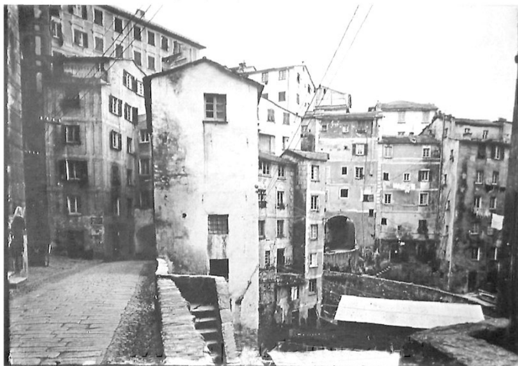
Prima dei lavori dello scalo di costruzione
